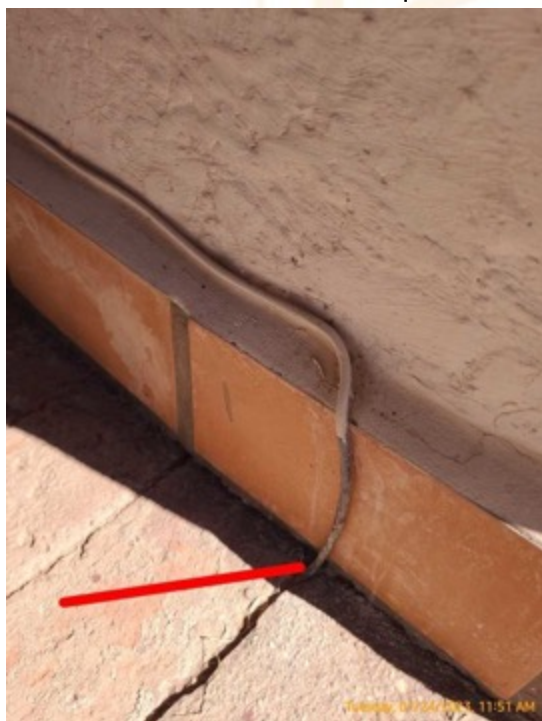
Línea de gas expuesta adyacente a la línea de gas de la puerta delantera visible en la grieta
