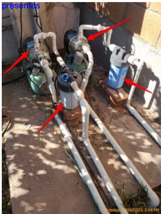
bombas para tinacos con filtros en línea
