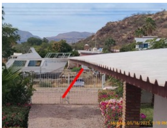
Cambio de elevación de la línea del techo en la soldadura: inmersión no activa en el techo hacia la esquina frontal
