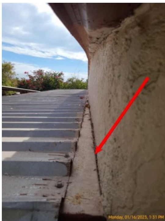
porche trasero extremo norte sin intermitente / cortocircuito / vista superior esquina
