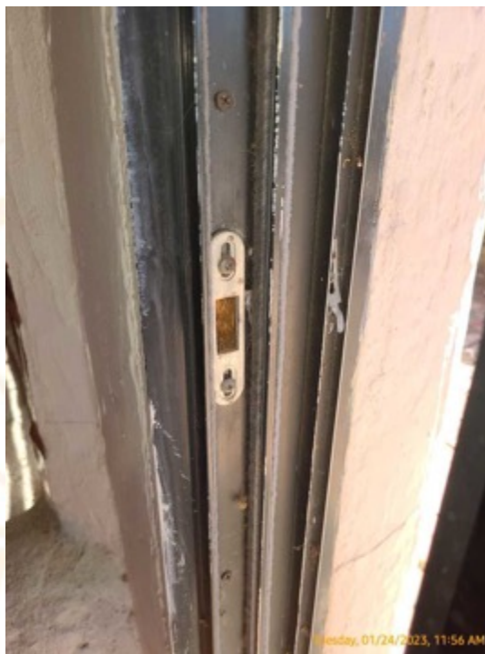
El pestillo y el mecanismo No coinciden
