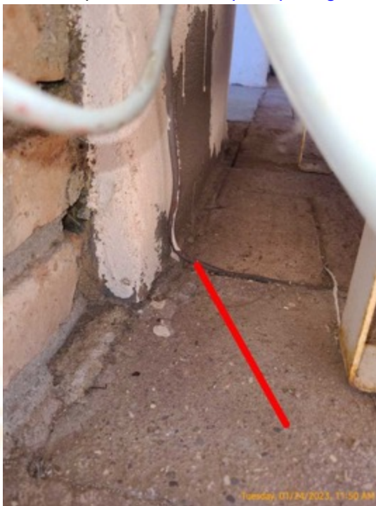
Línea enterrada. Sin protección contra la corrosión de cor
