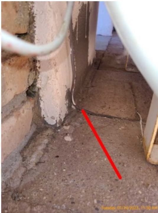
Línea enterrada. Sin protección contra la corrosión
