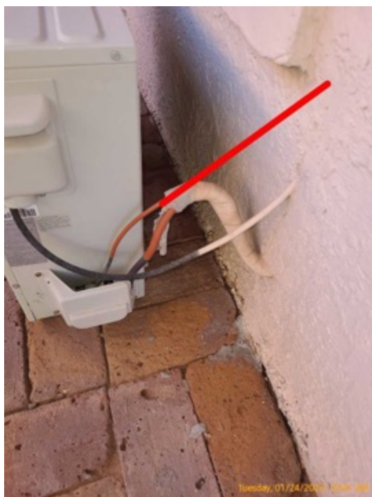
Falta aislamiento de la BDRM frontal
