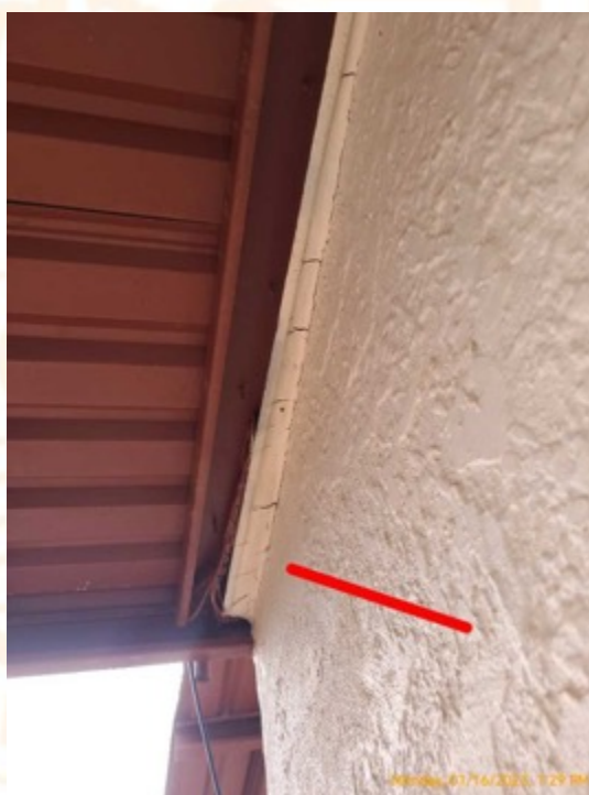
porche delantero sin borde de goteo
