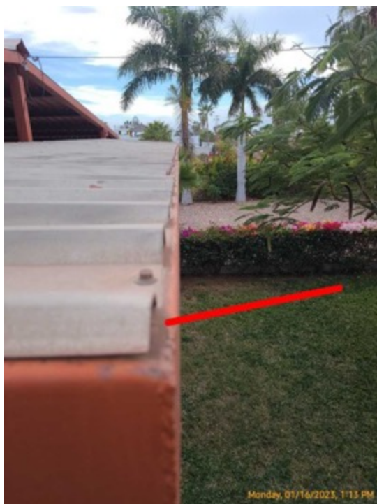
porche delantero sin borde de goteo
