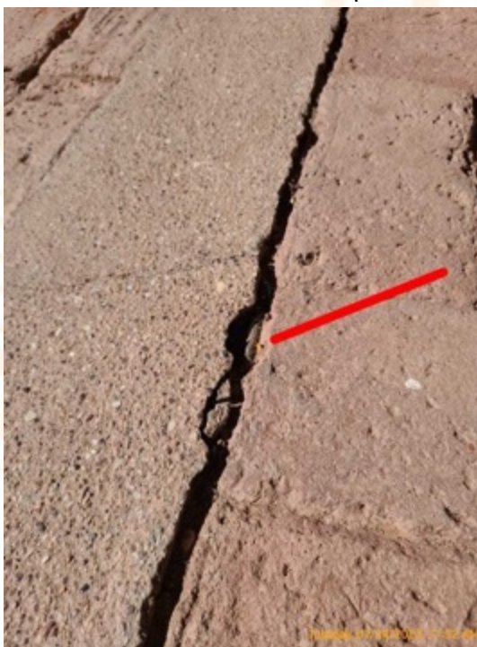
Línea de gas expuesta adyacente a la línea de gas de la puerta delantera visible en la grieta
