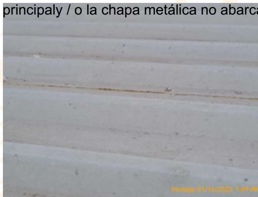
La pintura aparece sin ampollas con óxido mínimo
