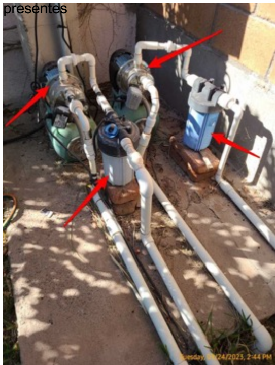
bombas para tinacos con filtros en línea
