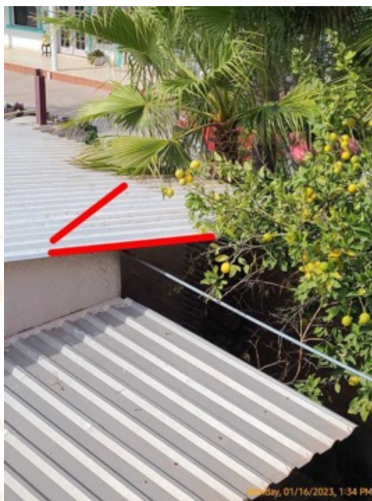
porche trasero extremo norte sin intermitente / cortocircuito / vista superior esquina
