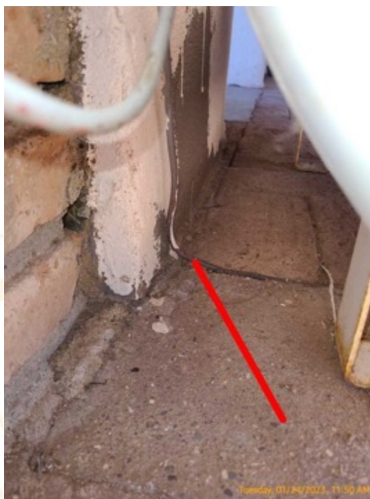
Línea de gas sin protección que ingresa a la pasarela debajo del tanque
